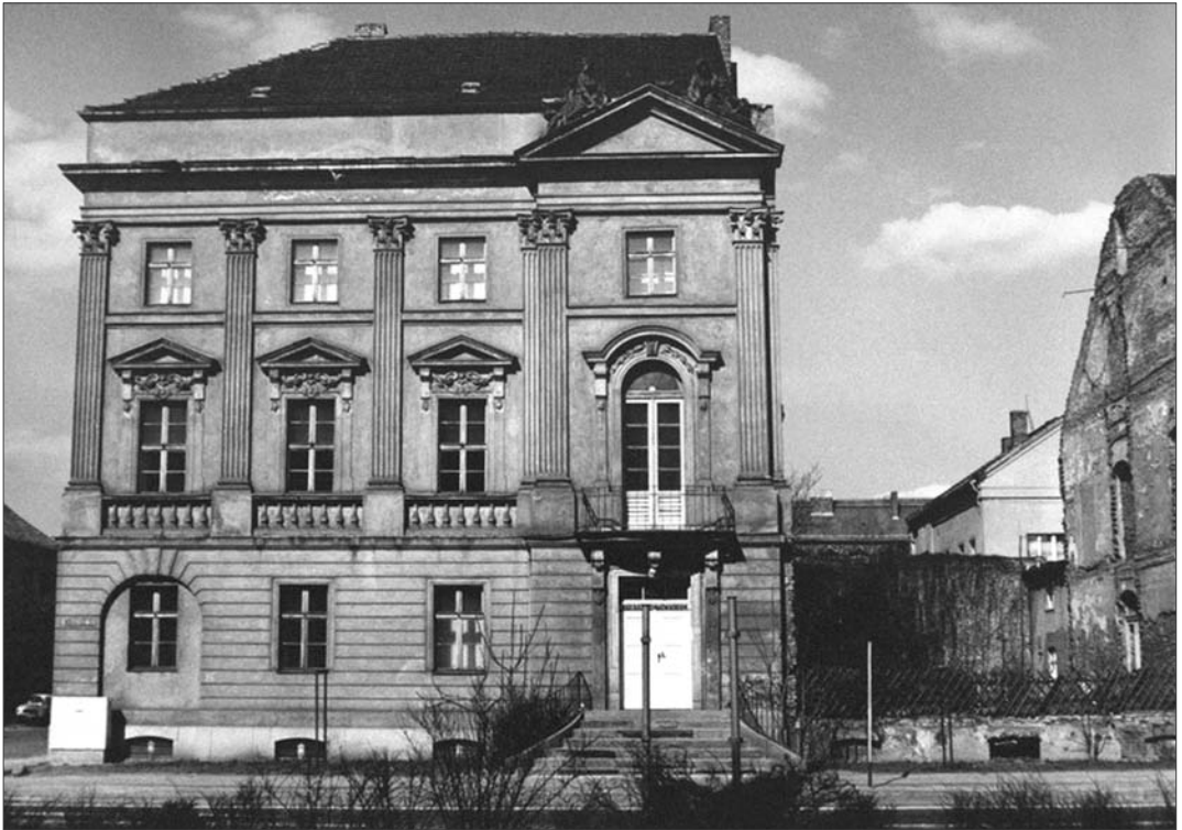
Abbildung 10: Das Museumsgebäude vor der Generalsanierung. Foto: Archiv Naturkundemuseum Potsdam.
